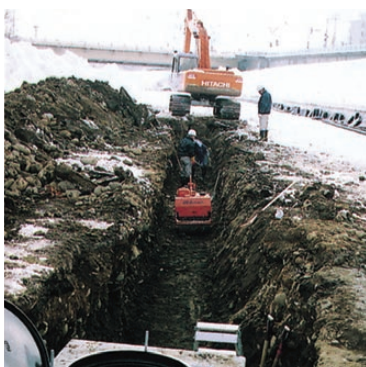
将挖出的土回填
