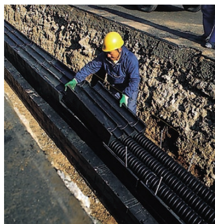
铺设无需使用重型机械
