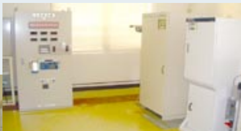
排水自動監視機器
