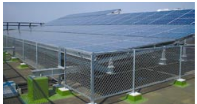
当社が施工した返子市役所殿屋上納入 30kW 太陽光発電システム (2003年2月竣工)
