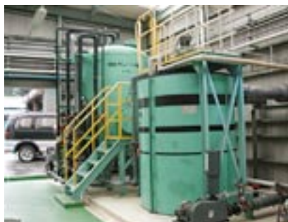
緊急時雨水処理施設
