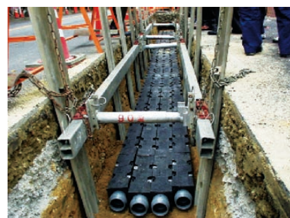
リサイクル管路防護台施工例
