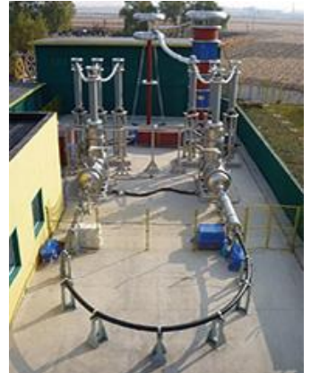
高温超電導電力ケーブル
