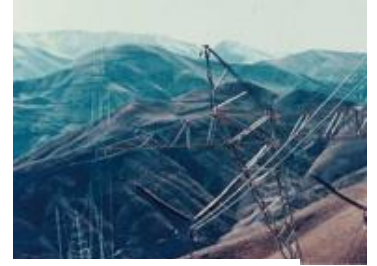
イラン送電線工事
