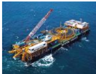
海底送電ケーブル敷設の様子
