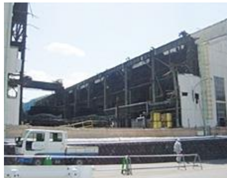
全面復旧に向けた作業が続く工場
