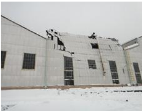
雪害直後の屋根が崩壊した工場
