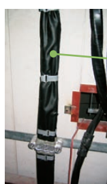
Cables wrapped in PROTECO Sheet P2-eco
