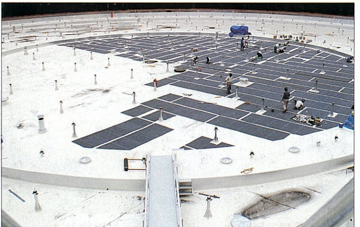
油库屋顶隔热材料
