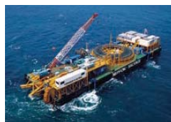
海底送電ケーブル敷設の様子
