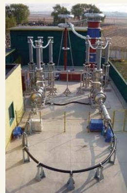
中国での世界最高水準の超電導ケーブルの実証試験の様子
