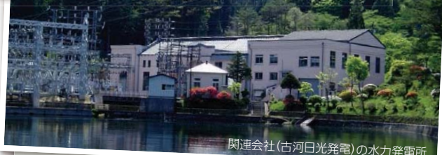
関連会社(古河日光発電)の水力発電所
