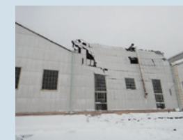
雪害直後の屋根が崩壊した工場
