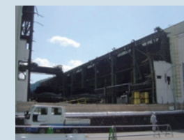
全面復旧に向けた作業が続く工場
