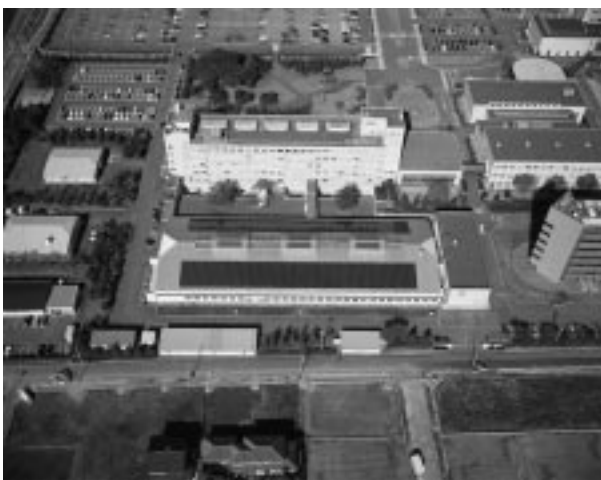
図 4 太陽光発電システム Solar energy power plant
