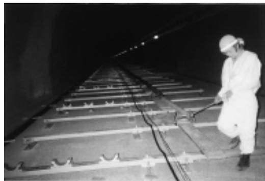
写真3 洞道内ケーブル布設
