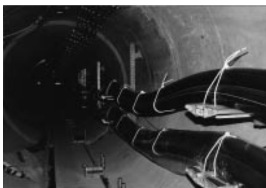
写真3 洞道内スネーク布設 Cable snaking on tunnel
