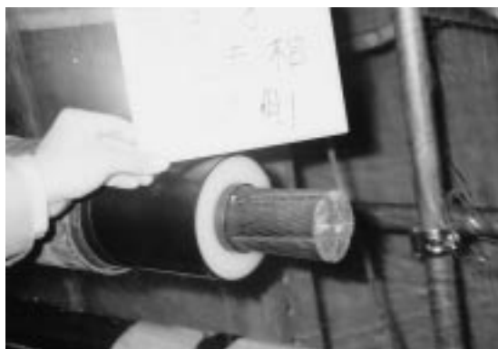
写真3 洞道内スネーク布設 Cable snaking on tunnel
