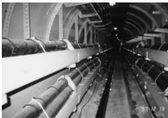
写真2 洞道内ケーブル布設 Cable laying on tunnel
