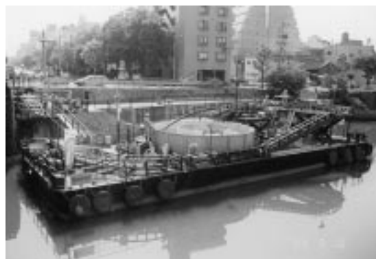
写真1 地上部ケーブル布設 Cable laying on ground
