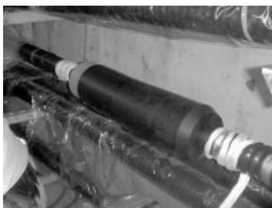
図5 110 kVゴムユニットの収縮状況 Assembly of cold shrinkable joint for 110-kV XLPE cable
