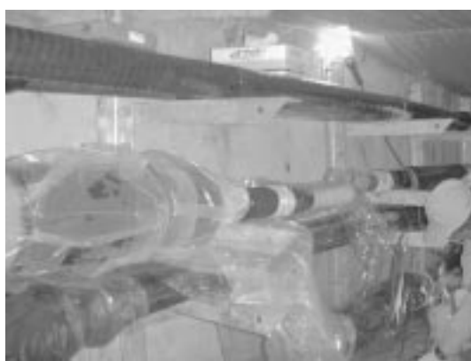
図4 ケーブルに挿入した110 kVゴムユニット 110-kV rubber unit inserted to the cable
