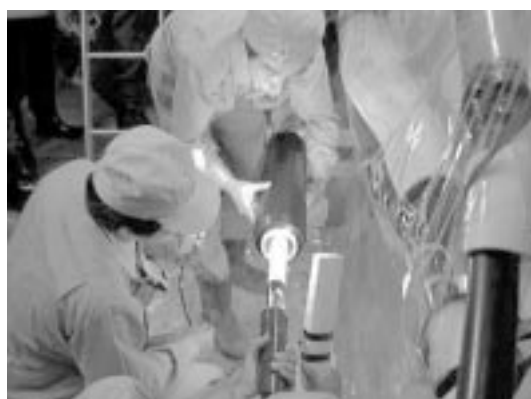
図7 ケーブルに挿入した66 kVゴムユニット 66-kV rubber unit inserted to the cable
