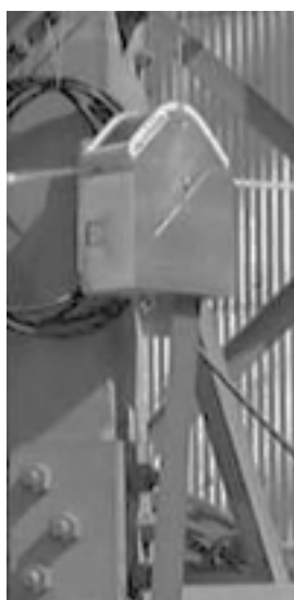
写真1 閃絡表示器 Appearance of fault point locator
