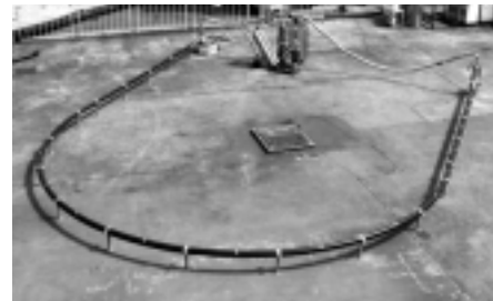
写真 2 30 m モデルケーブル試験 The 30 m HTS cable installed in oxbow shape in Furukawa's laboratory for tests
