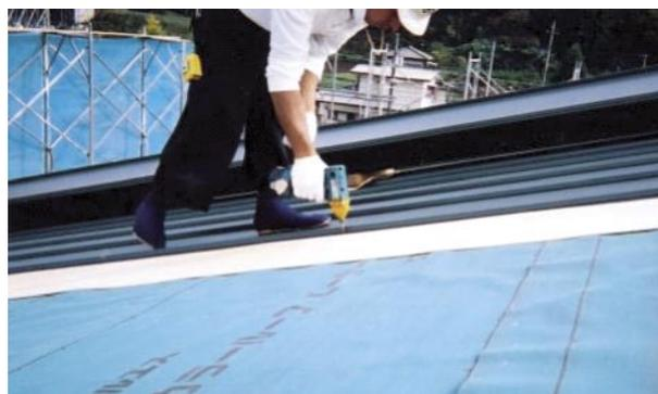
図3 縦ぶき屋根仮止め材の使用例
