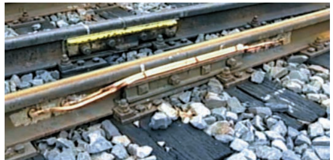
図1 レールボンドの取付例 Rail bond installed on the rail.
