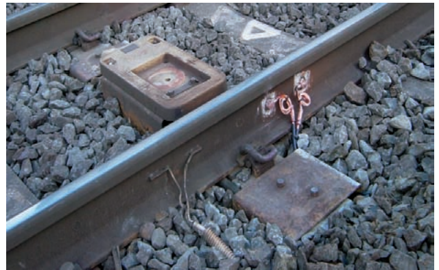
図2 信号ボンドの取付例 Signal bond installed on the rail.
