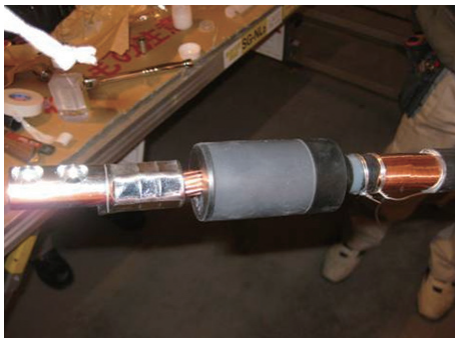
図4 ケーブル加工 Jointing process.
