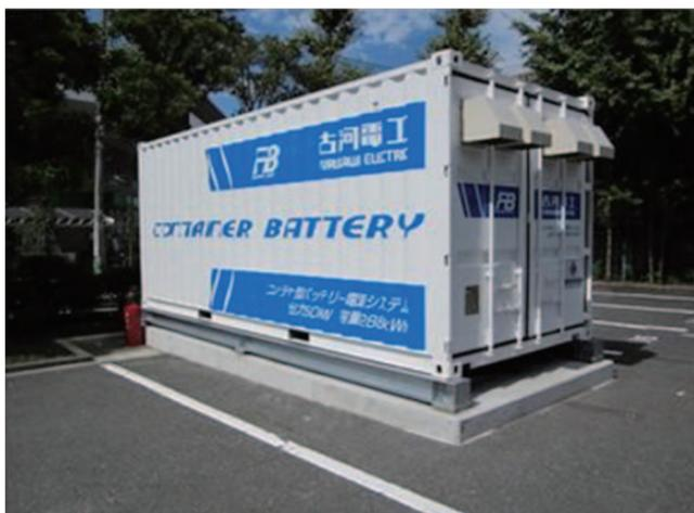
図1 海上コンテナを用いたパッケージ型蓄電システムの外観
