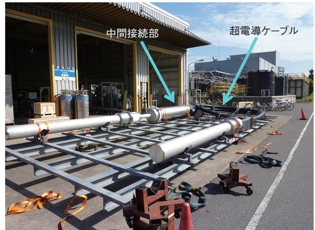
図14 中間接続部付超電導ケーブルの輸送
