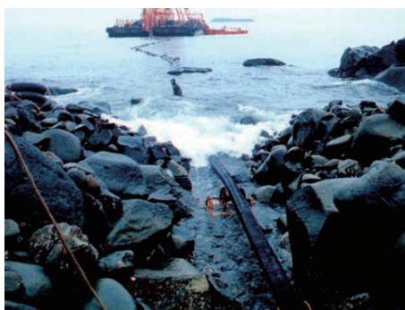
トレンチ布設状況
