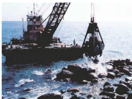
トレンチ掘削状況
