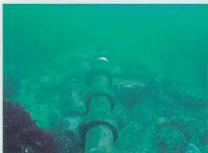
▲取水管の海底布設
