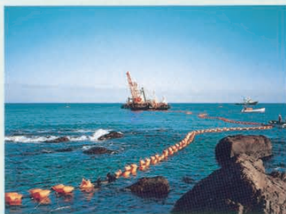
▲取水管の陸揚げ
