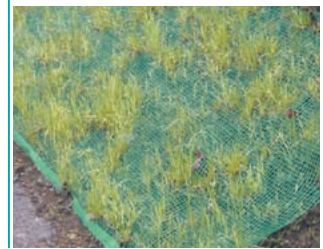
土木工事用植生ネット (エフマックシート) トウモロコシなどの植物資源からとれるデンプンを原料に、乳酸発酵を経て化学合成法でつくられるポリ乳酸繊維 (ユニチカ「テラマック」) と種子・肥料入りシートで構成されています。
