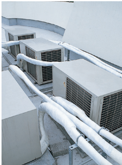
業務用エアコン断熱配管
