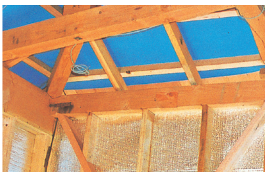
屋根裏断熱施工
