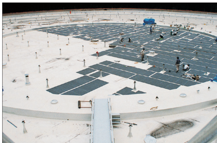
石油タンク屋上断熱材
