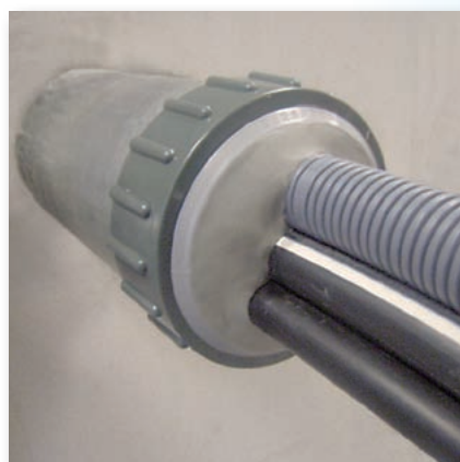
鋼製電線管貫通部施工例
