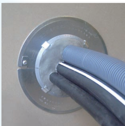
丸穴貫通部施工例
