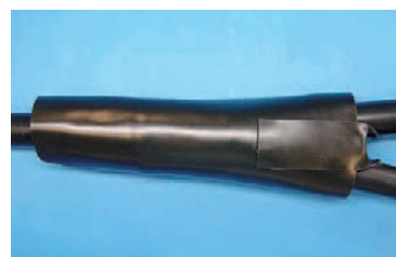
⑥分岐線部に粘着カバーを巻きます。
