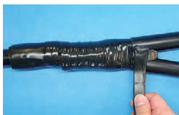
④絶縁テープ巻き、防水パテで谷を埋めます。
