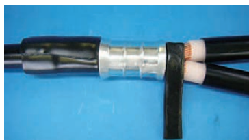
②防水パテ、粘着カバーをコネクタの径に合わせます。
