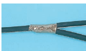
②耐火テープを巻きます。
