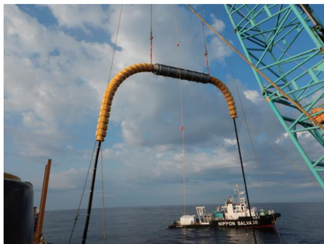
図10 海底ジョイント沈設作業
