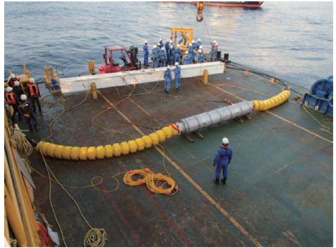
図5 22 kV用海底ジョイント外観
