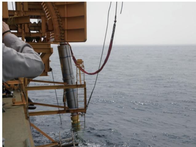
図9 海底ジョイント沈設作業
