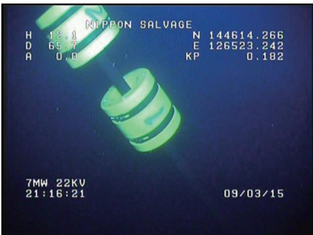
図12 ROVでの線形確認
