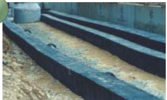
“孔多くん”布設完了。
