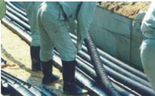
構造体ユニットの溝に沿って内管をいれます。
