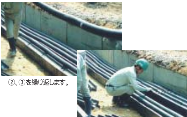
中段ユニットを下段と千鳥構造になるよう半分ずらして並べます。
