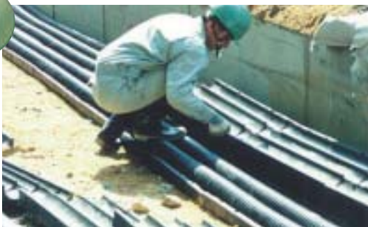
中段ユニットを下段と千鳥構造になるよう半分ずらして並べます。
