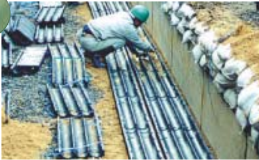
まず構造体ユニットを敷きます。
