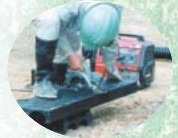
構造体ユニットの切断
