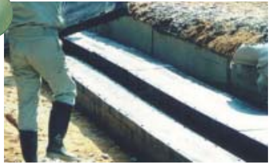
上段を中段ユニットと半分ずらし蓋をします。
