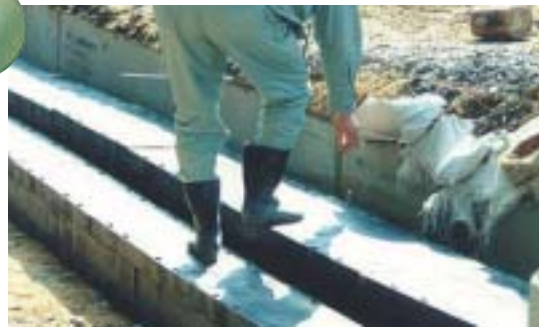
差し込みピンを挿入します。 (1構造体ユニット当たり、対角で2本の差し込みピンで固定します)
