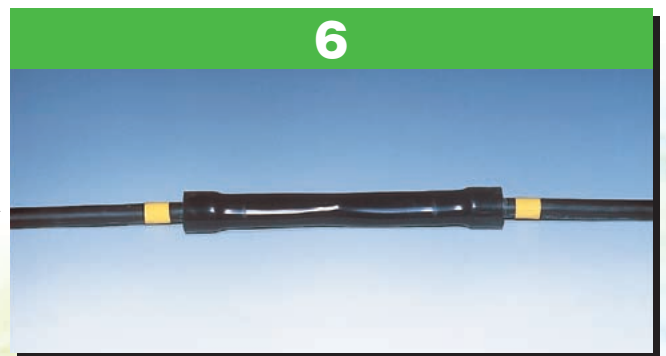
逆端のコア紐を引き抜き完了です。
