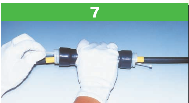
チューブ中央部をしっかりと押さえながら、コア紐を引き抜きます。
