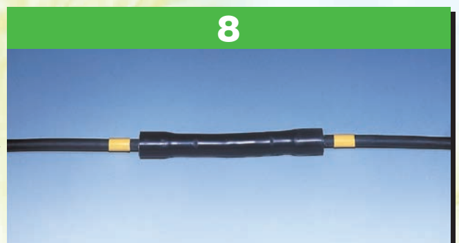
逆端のコア紐を引き抜き完了です。
