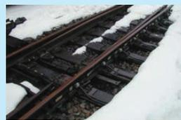
ポイントに積もった雪をヒーターで融かす電気融雪器が安定運行を可能にしています。**融雪器用電源ケーブル**は積雪地域の鉄道で多く使われています。
