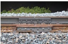
レールは温度によって伸縮するため継目は隙間を設けて敷いてあります。しかし、それでは電気や信号の回路が途切れてしまうので、両方のレールを電氣的につなぐのがレールボンドです。**銅テルミット溶接工法のレールボンド**は、作業性が高く、強度・耐久性に優れています。
