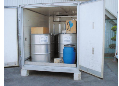
PCB保管状態
