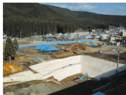
栃木金属工業の土壌対策現場
