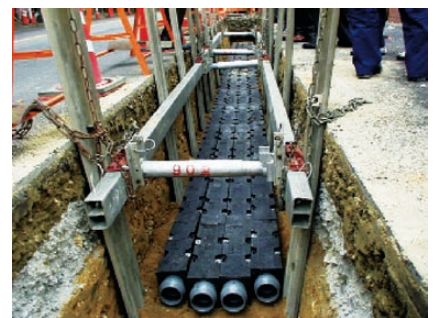
リサイクル管路防護台施工例
