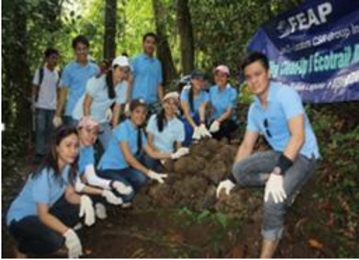
マキリン山での歩道整備
