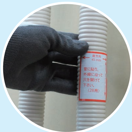
① 管の水分・汚れを落とし 付属シールを貼る
