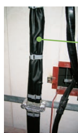
Cables wrapped in PROTECO Sheet P2-eco
