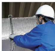
断熱ダクトピース 同士を接続
