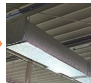
ダクト断熱エース 付きダクトの完成
