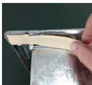
ダクトフランジに インナーテープを 貼付け
