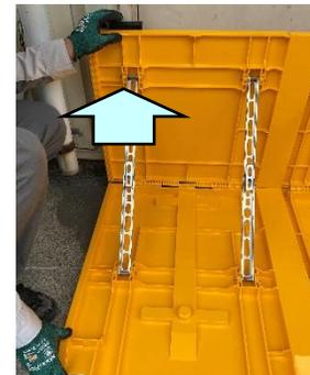
後端部のF-Shieldを組み立て、壁面用止水材に押し付ける。
