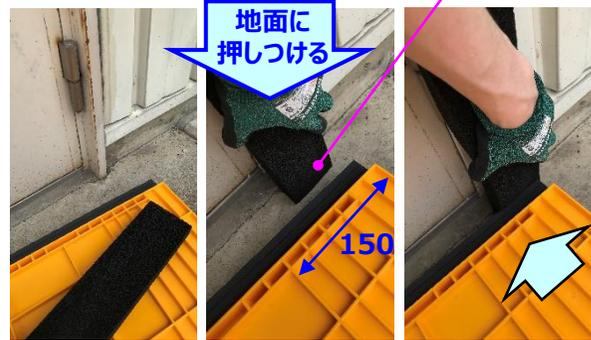
扉枠の右側に壁面用止水材を設置し、**F-Shield先端用**で壁面用止水材を挟みこむ。壁面用止水材は地面に押しつけること。
