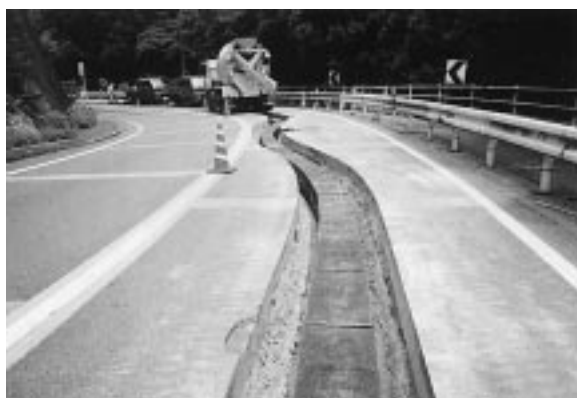
図 8 孔ーくん現場施工例 Construction site
