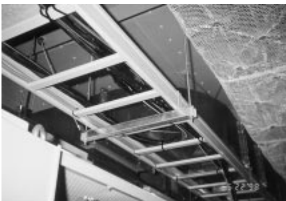
写真 4 布設例 (2) Example of installation (2)
