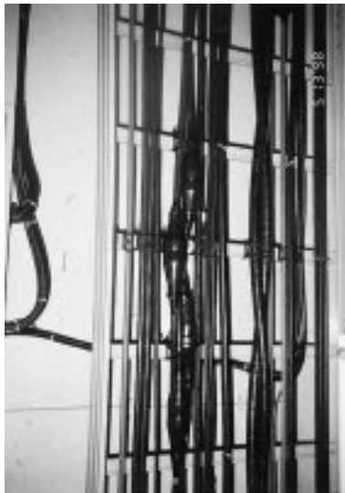
写真 3 布設例 (1) Example of installation (1)
