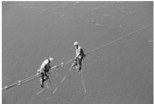
写真5 No.10 クロスワイヤダンパ取り付け状況
