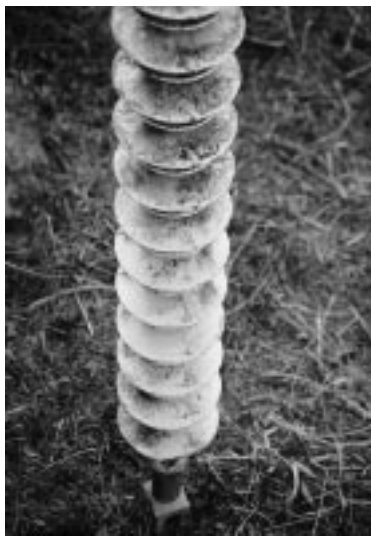
写真 2 アーク試験後の複合がいし状況 Composite insulator after exposure to power arc
