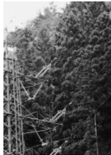
写真 4 実線路適用例 Composite insulator applied for actual service line
