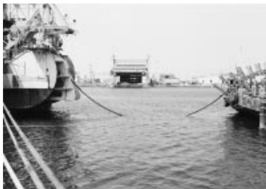
写真4 海底ケーブルの船積み Shipment of the submarine cable
