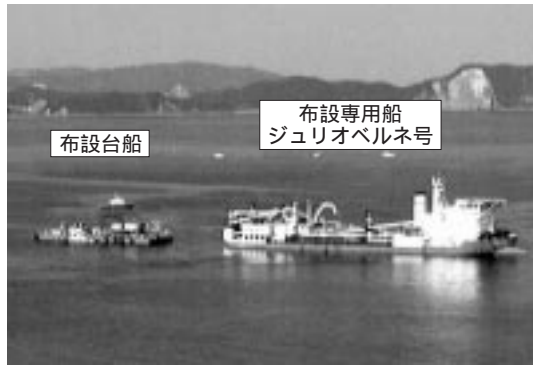
写真6 ケーブル積替え状況 Transshipment of cable
