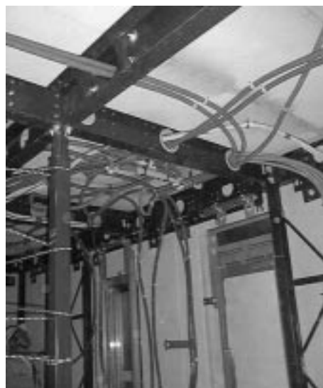
写真8 施工状況(2) Construction site (2)
