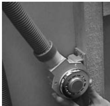
写真4 水栓ボックスの固定 Setting a tap joint box
