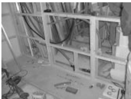
写真7 施工状況(1) Construction site (1)
