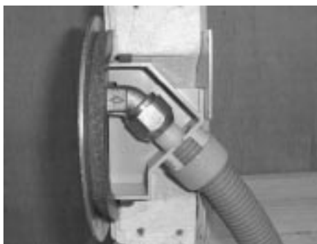
写真2 外壁用水栓ボックス Joint box penetrating outer wall
