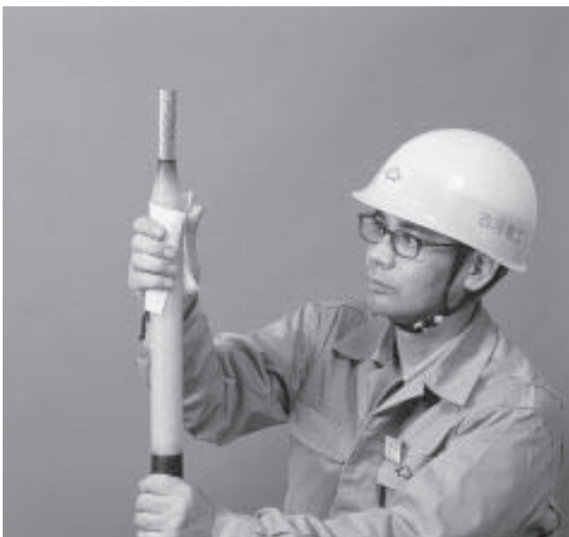
写真1 ケーブル洗浄作業 Cable cleaning work
