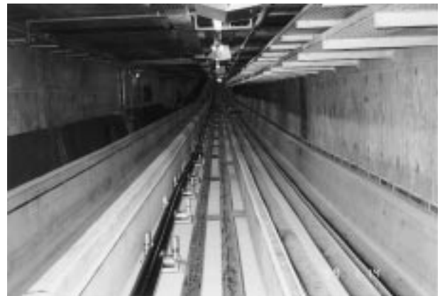
写真3 洞道内ケーブル布設 Cable laying on tunnel
