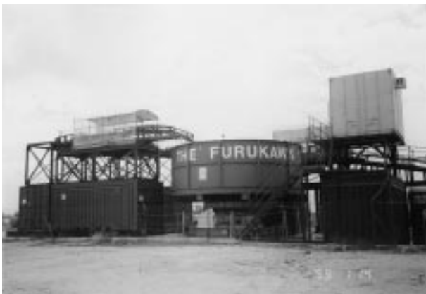
写真2 地上部ケーブル布設 Cable laying on ground
