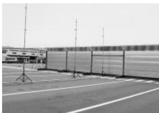
(b) 防音壁全体
