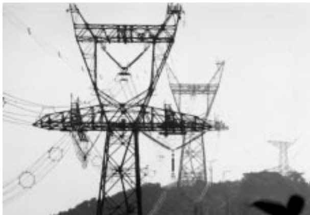
写真1 架線試験状況 Installation
