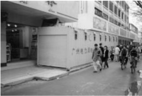
写真1 広州市内のケーブルジョインティングハウス 220-kV XLPE cable jointing-house in Guangzhou City
