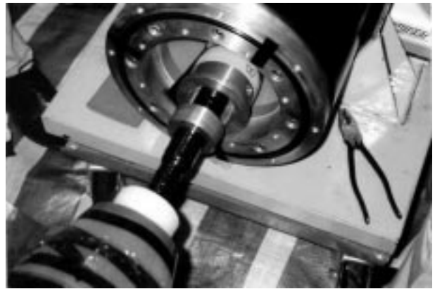
写真2 220-kV PJ中間ジョイントの組み立て 220-kV prefabricated joint in assembling
