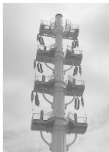
写真4 66 kV 生浜線 1号鉄塔 (複合がい管EB-A)
