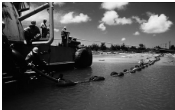
写真2 布設の写真 Cable landing on Miyako-shima
