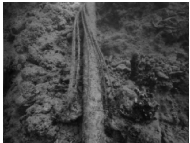
写真1 既設ケーブルの写真 Submarine cable laid 28 years ago
