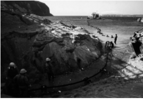
写真3 新島側陸揚げ状況図 Cable landing on Niiijima
